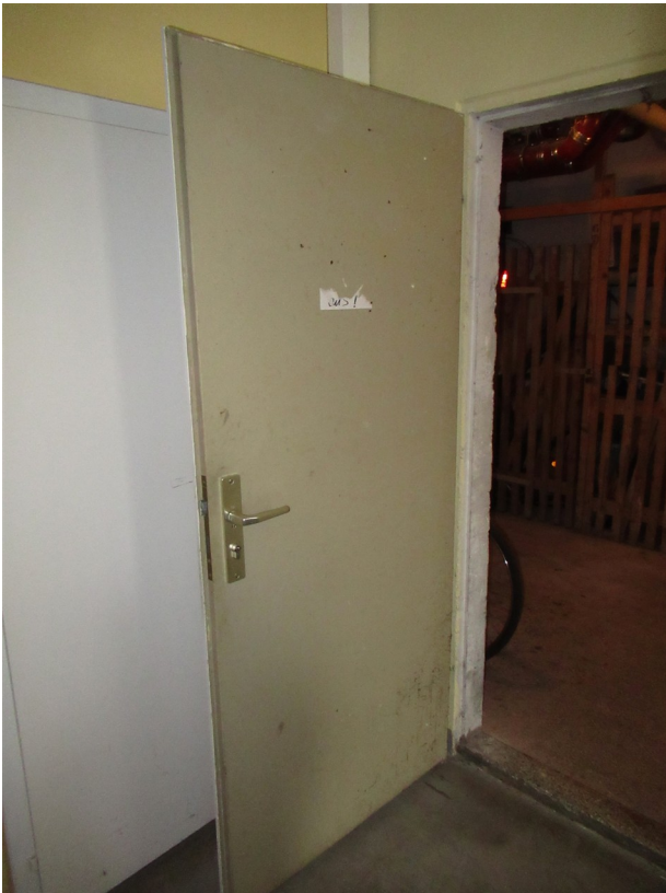
Bild 8: Holztür zwischen Treppenraum und Kellerbereich im Untergeschoss
