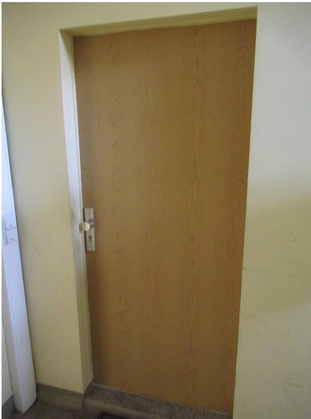
Bild 11: Wohnungseingangstür in Holz Ausführung im Treppenraumbereich
