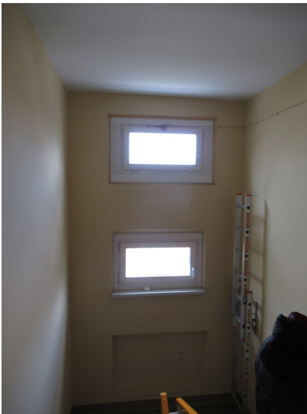
Bild 12: Hofseitige Treppenraumfenster in den Zwischengeschossen sowie oberstes Fenster zur Rauchableitung
