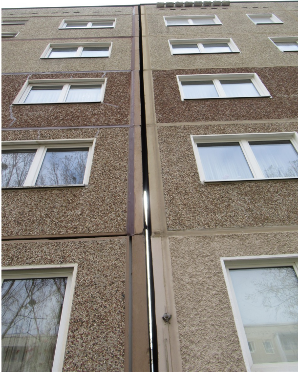
Bild 15: Gebäudetrennfuge zwischen Biberkiez 31-37u und dem benachbarten Gebäude
