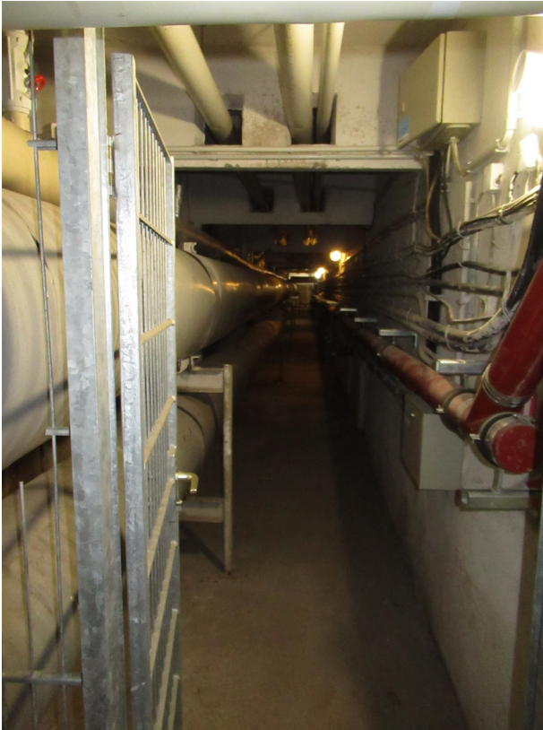
Bild 9: Von allen Aufgängen zugänglicher Kollektorgang im Untergeschoss mit technischen Installationen
