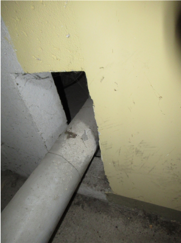
Bild 7: Nicht abgeschottete Rohrdurchführung im Untergeschoss im Bereich des Treppenraums
