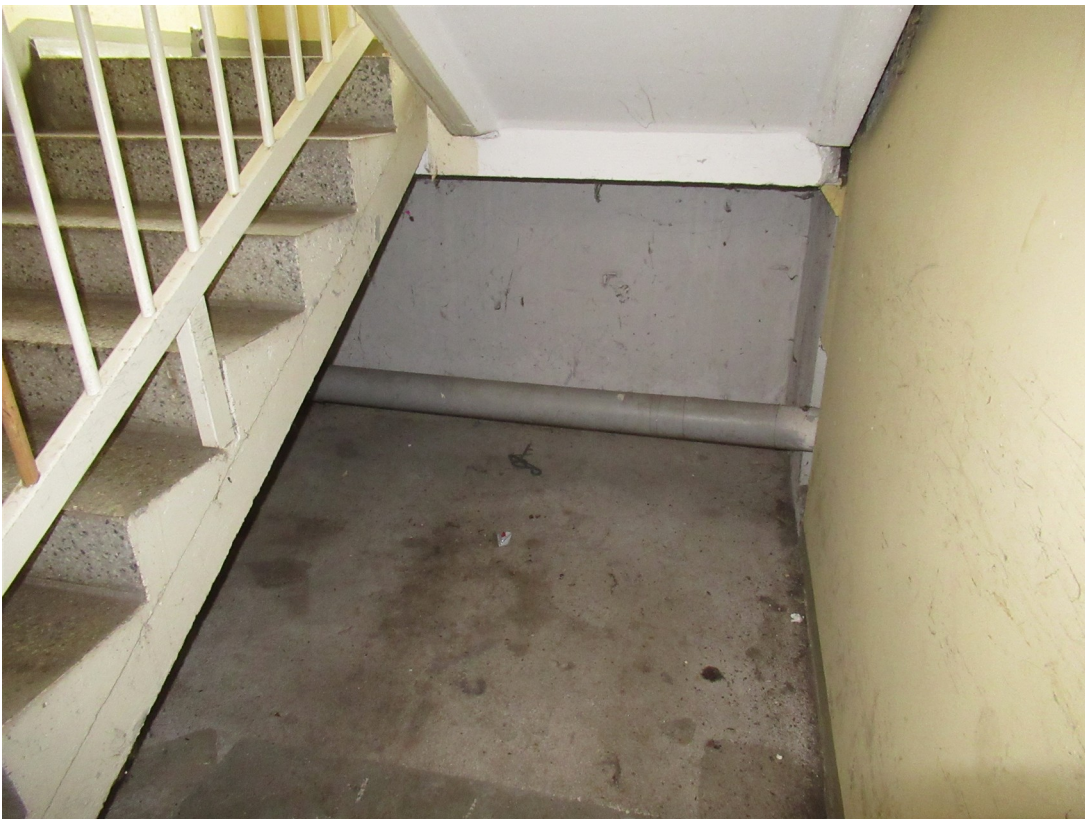
Bild 6: Offen geführte Rohrleitungsinstallation im Untergeschoss unterhalb des Treppenpodests
