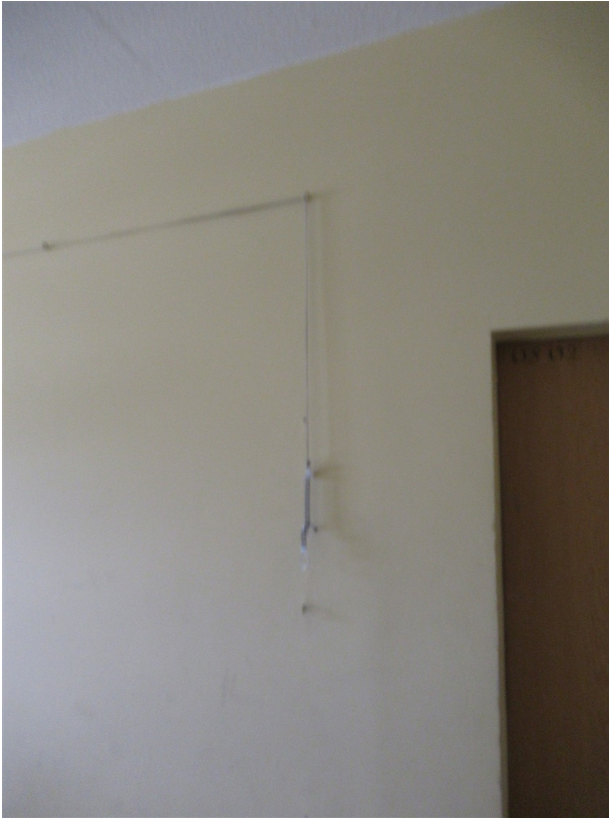
Bild 13: Bedieneinrichtung zur Rauchableitung
