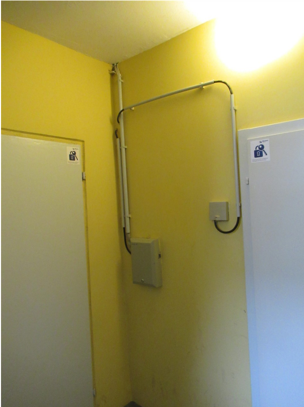
Bild 5: Offen geführte elektrische Leitungsinstallationen im notwendigen Treppenraum
