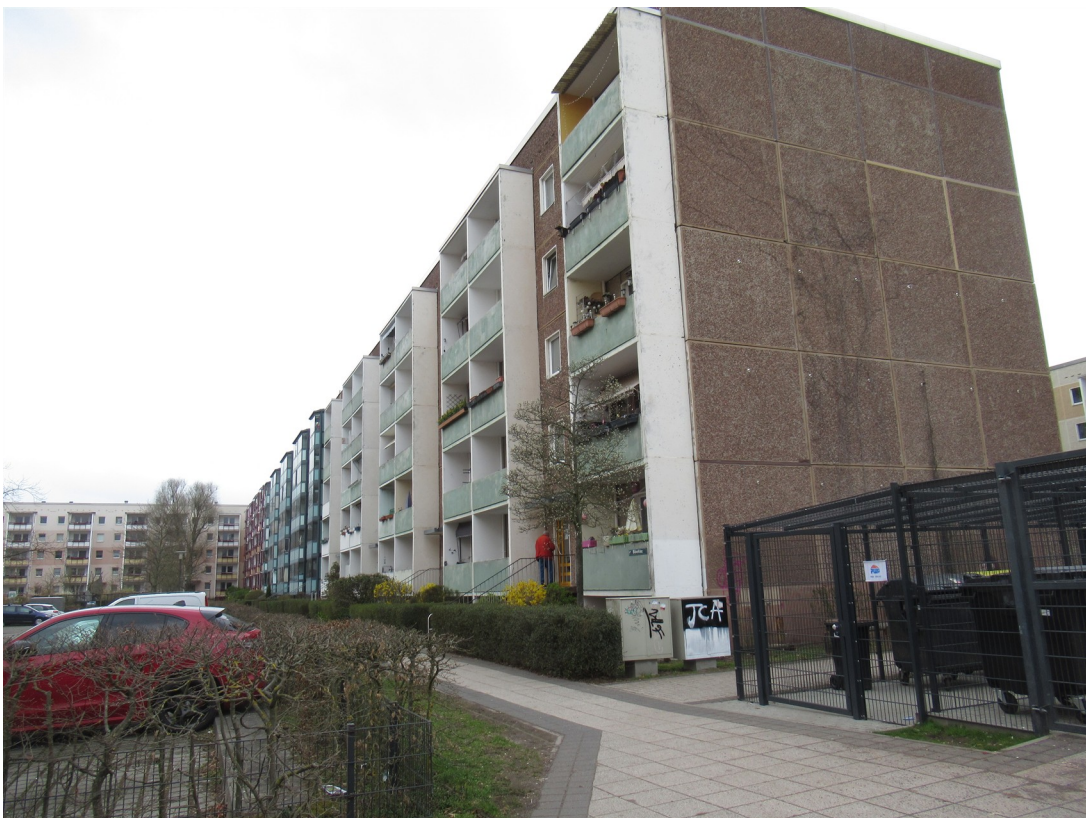
Bild 2: Ansicht der straßenseitigen Fassade mit Balkonanlagen und Giebelwand
