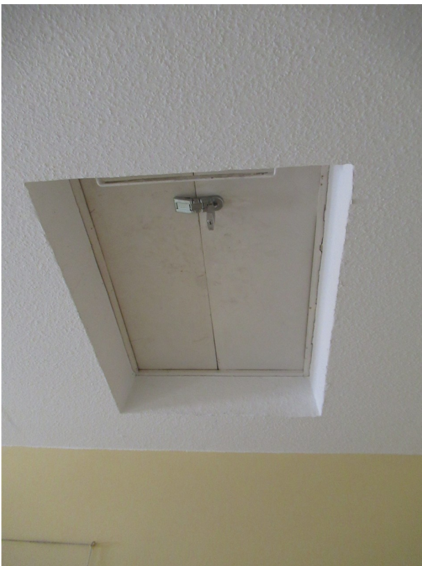
Bild 14: Deckenklappe im oberen Abschluss des Treppenraums
